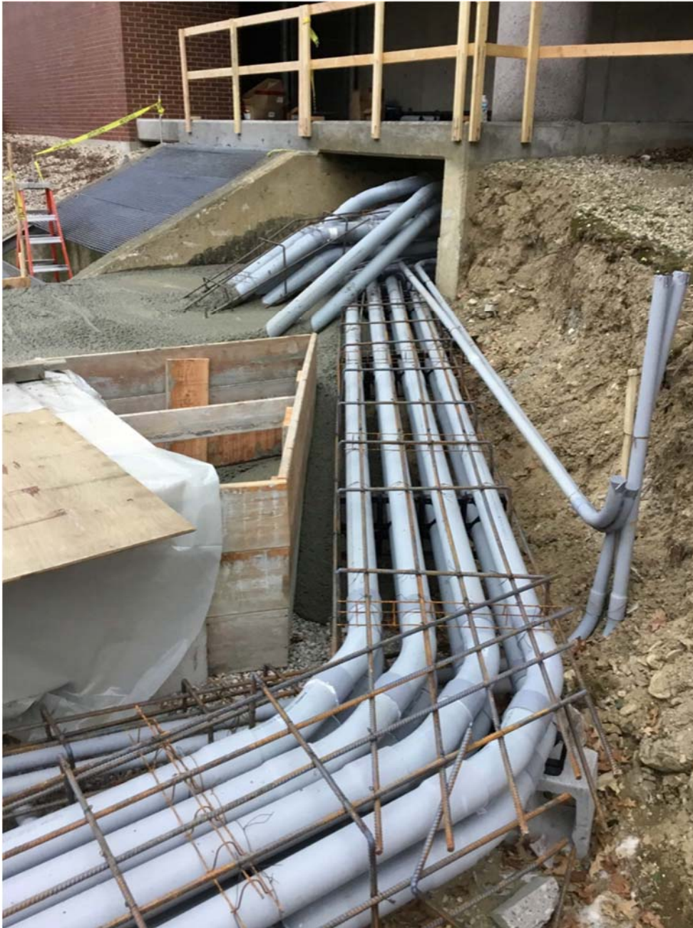
Exterior Conduit Runs
