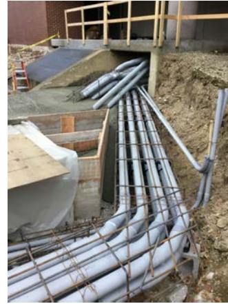
Transformer Conduits & Screen Wall
