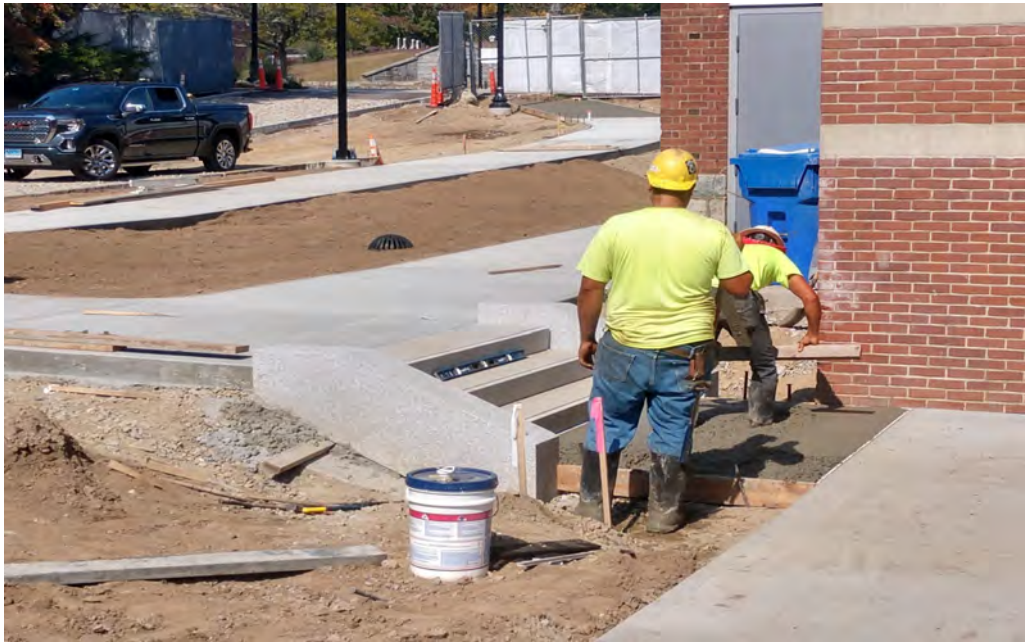
Sidewalk Pour at new Granite Stairs
