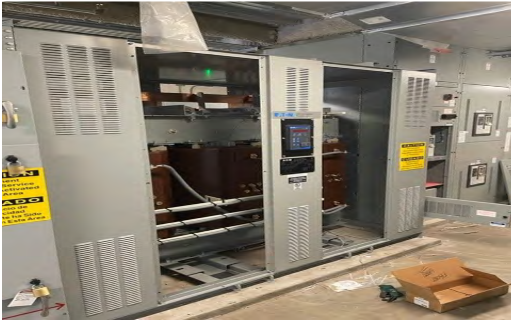
Interior Gant - New Transformer
